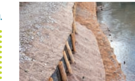
Confortement des berges à Grans
