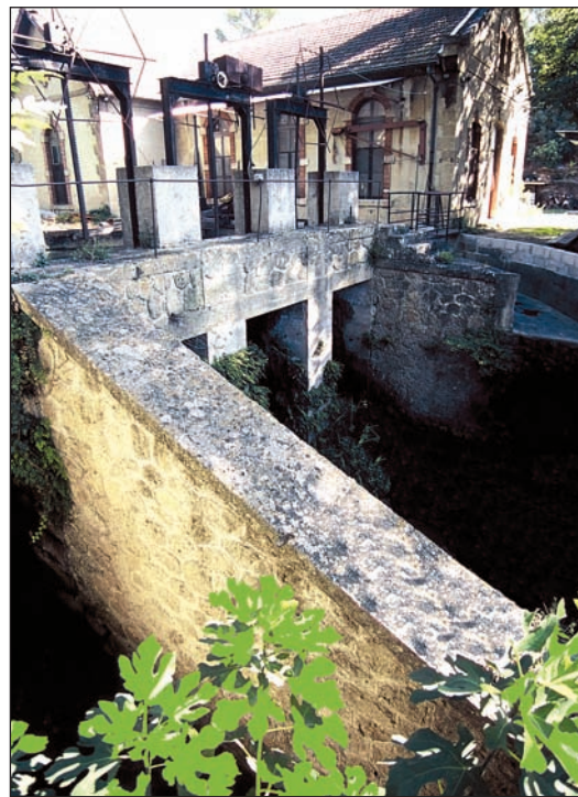
Usine électrique de Pont de Fumet à Grans
