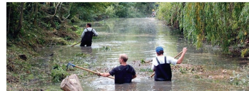
Restauration de la Touloubre à Pélissanne
